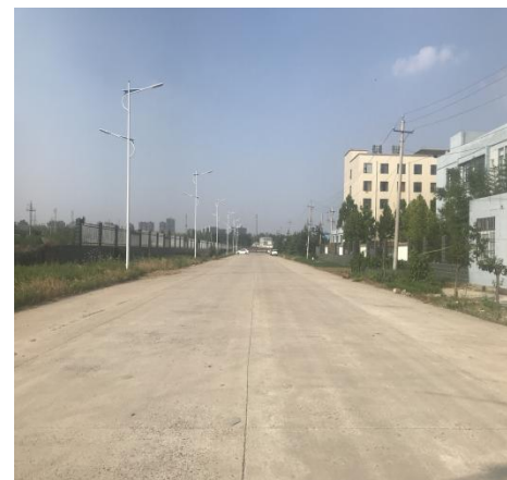
车间所在厂院西侧
