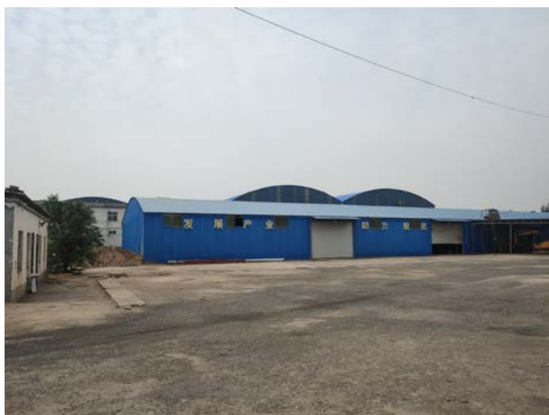
项目租用厂房南侧
