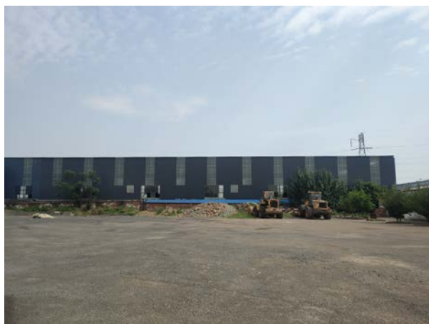
项目租用厂房北侧
