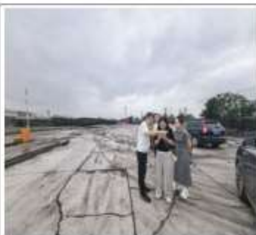
工程师现场踏勘图
