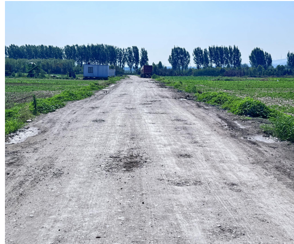
厂区东侧进场道路
