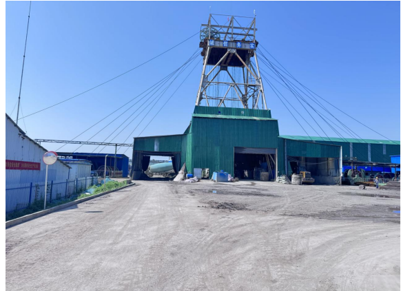
进风井施工现状
